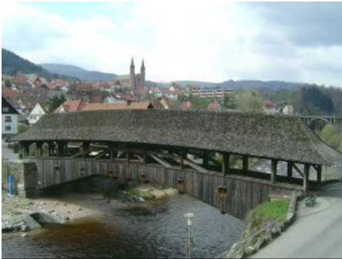
Abbildung 4: alte überdachte Straßenbrücke
